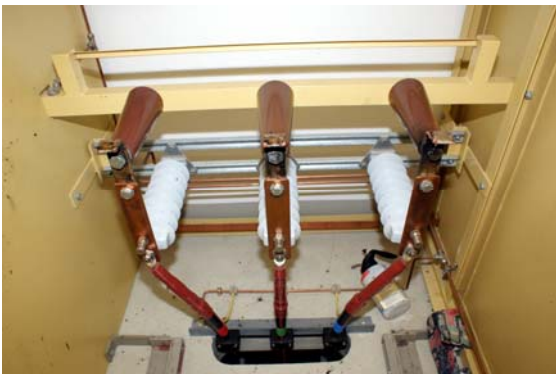
Bild 3 Arbeitsstelle war noch unter Spannung und nicht geerdet. 5 Sicherheitsregeln nicht korrekt angewendet.
