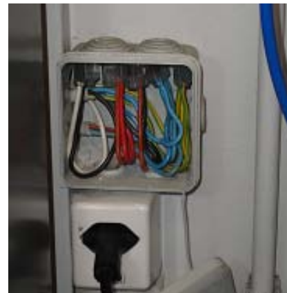
Bild 5 Brücke Neutralleiter-Schutzleiter.
